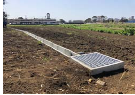
整備された水路(泉区下飯田町)
