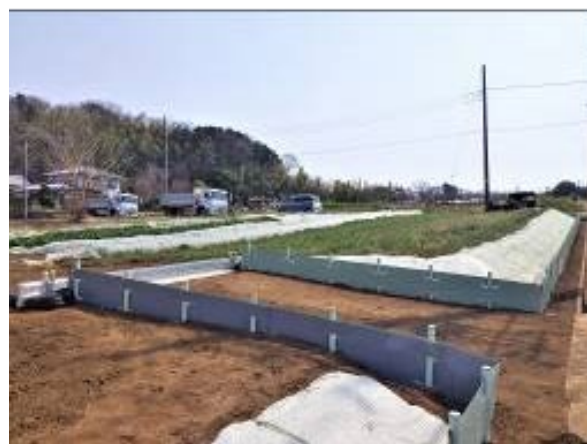
事業① 農景観保全整備 (土砂流出防止対策)(都筑区)
