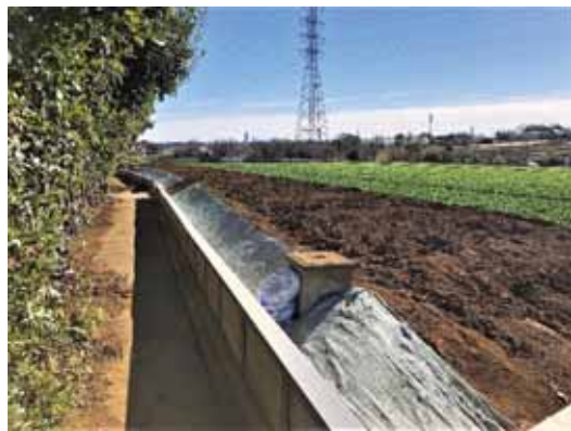
土砂流出防止対策を実施した農地 (都筑区東方町)
