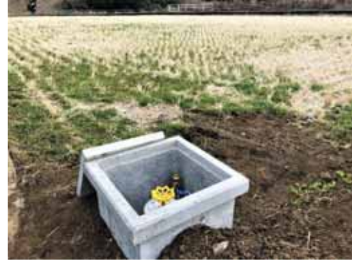
水田の用水路の修繕(泉区和泉町)
