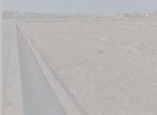
水田の用水路の修繕(泉区和泉町)
