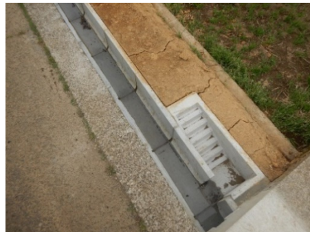
【改修した水路】（青葉区）
