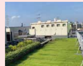
病院屋上での緑化整備(鶴見区)
