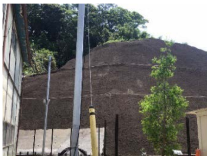
【法面の整備】 飯島町特別緑地保全地区（栄区）
