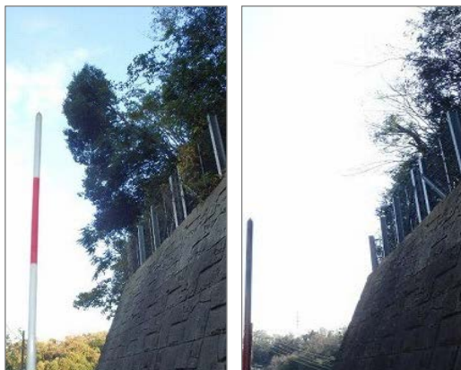
【維持管理の支援】 左：作業前 右：作業後（金沢区）
