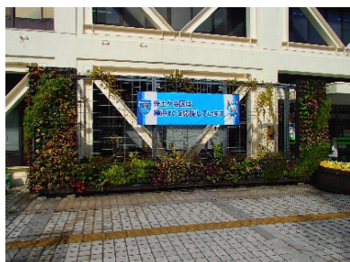
保土ヶ谷区庁舎（保土ヶ谷区）
