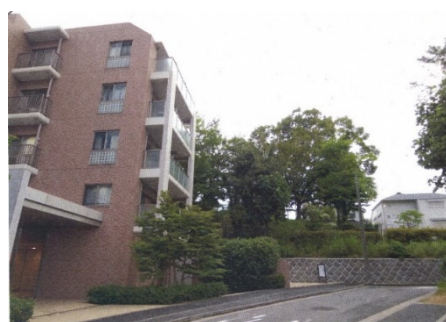
【保全契約の事例】（磯子区）
