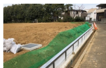
【土砂流出防止対策を実施した農地】（都筑区）
