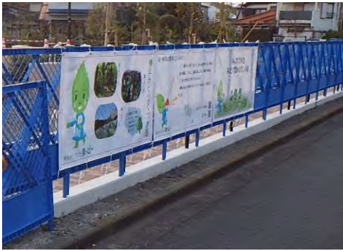
工事現場での現地表示
