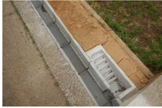
整備された水路(青葉区田奈町)
