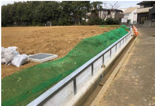
土砂流出防止対策を実施した農地 (都筑区東方町)
