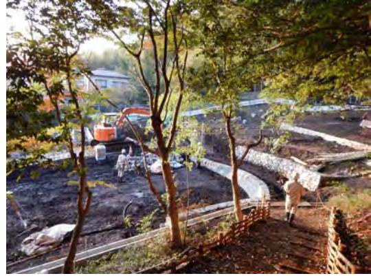
農園付公園 整備の様子 (都筑区／大榎杉の森ふれあい公園)
