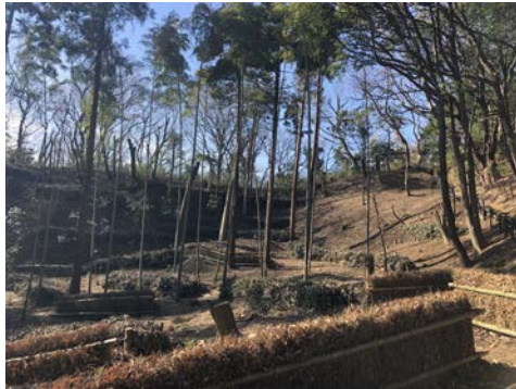
生物多様性にも配慮した防災や安全性の 対策工事を行った法面 (戸塚区／名瀬北特別緑地保全地区)
