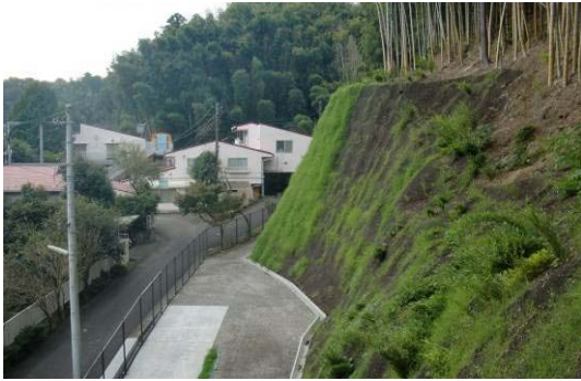
生物多様性にも配慮した防災や安全性の対策 工事を行った法面(戸塚区／舞岡ふるさとの森)
