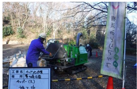
チップ化作業支援の様子(都筑区/茅ヶ崎公園)
