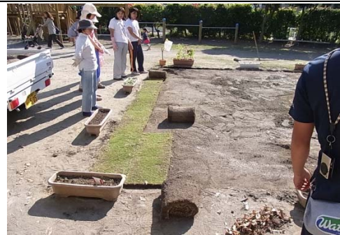
張芝（ロール）の施工状況
