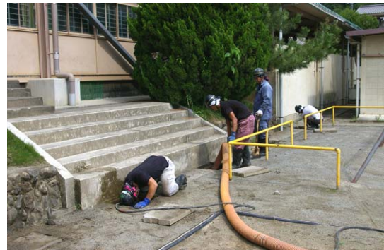
側溝（排水設備）清掃
