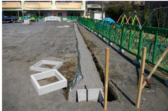
暗きょ排水設備 (碎石の下に穴の開いた管が埋められています)
