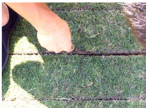
地面に切れ込みを入れる
