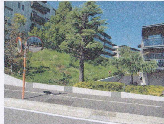
C棟法面(ハーブの丘)
