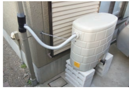
▲維持管理のための雨水タンクの設置
