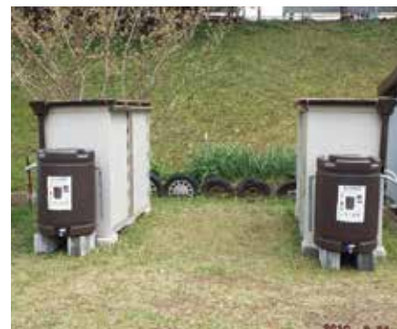
設置した倉庫と雨水タンク
