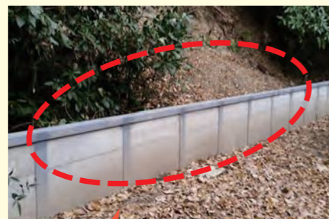
拡充した 助成内容 簡易土留めの 設置
