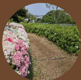
遊歩道への敷均し
