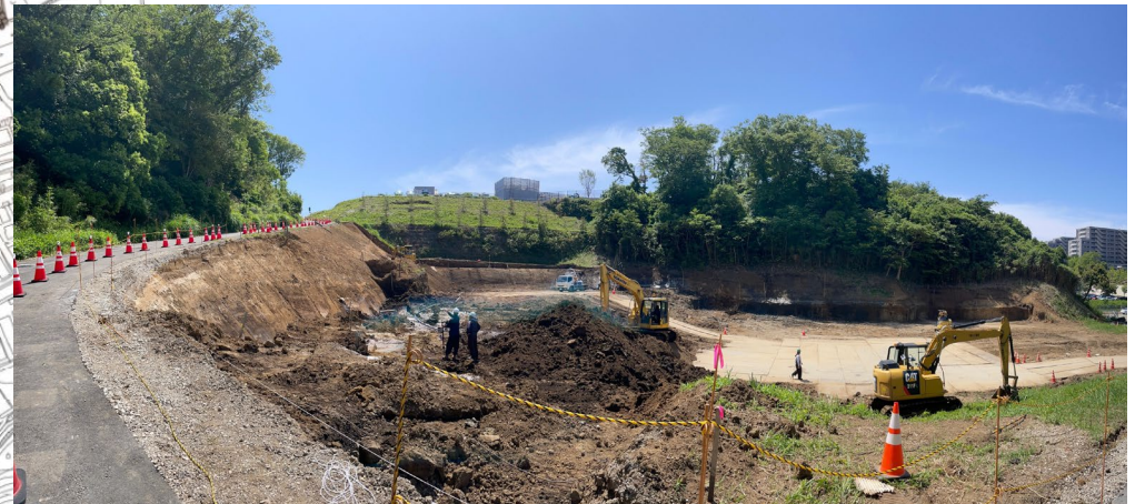
②スケートボード場 施工状況
