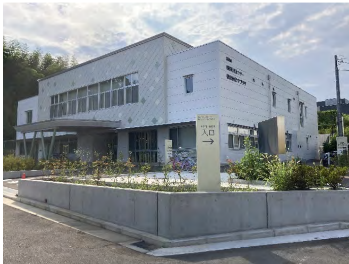
地区センター・地域ケアプラザ
