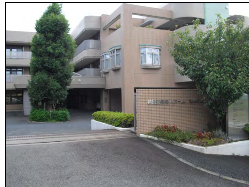
施設(和みの園)の外観
