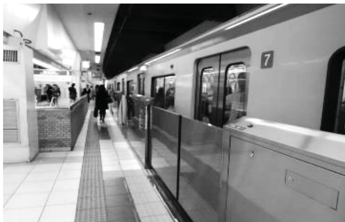
可動式ホーム柵の設置状況 (27年度整備：相鉄線横浜駅)
