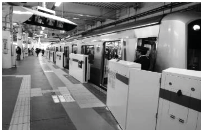
可動式ホーム柵の設置状況 (27年度整備：東急東横線菊名駅)
