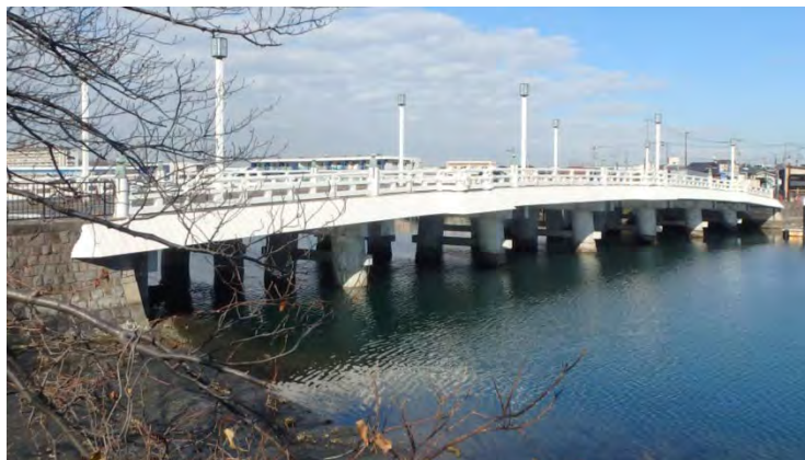
橋脚巻き立て等の耐震補強工事が完了した夕照橋（金沢区）
