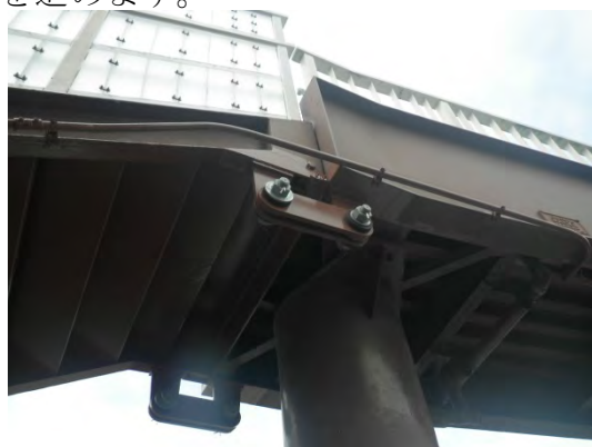
落橋防止装置:西町歩道橋(磯子区)
