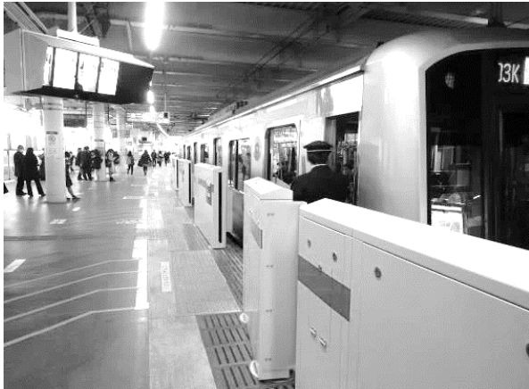
可動式ホーム柵の設置状況 (28年度整備：東急東横線日吉駅)
