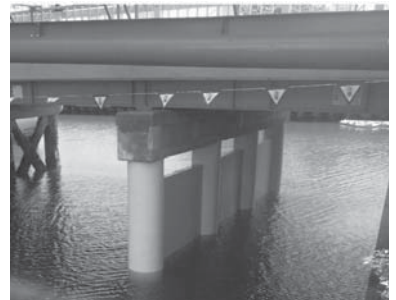
橋脚の補修(烏帽子田橋)
