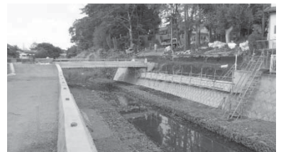
河川改修による護岸整備(和泉川)
