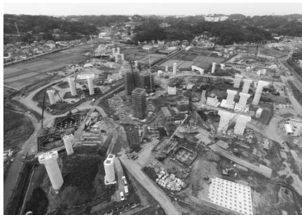
①栄IC・JCT下部工事 (栄区田谷町) 平成30年9月
