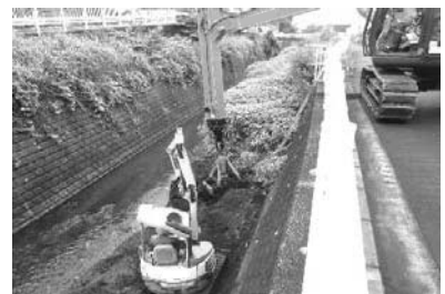
堆積土砂の掘削状況(帷子川)
