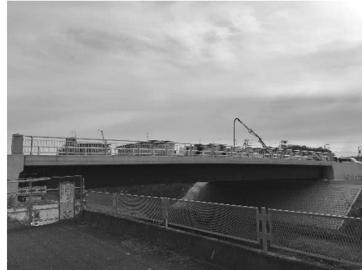
早淵川に架かる橋梁架設後の状況
