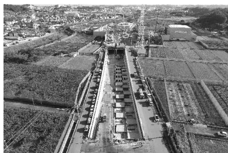
開削トンネル部付近（緑区北八朔町） （平成30年11月）
