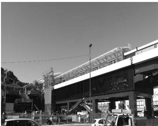
南側から見た新駅舎 平成30年11月
