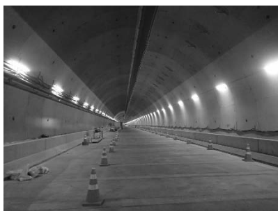
シールドトンネル坑内 （平成30年11月）
