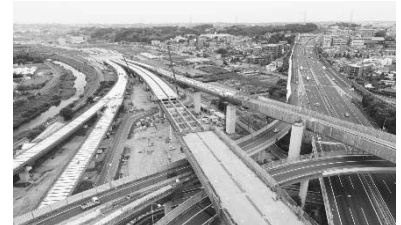
整備中の横浜環状北西線(横浜青葉IC・JCT)
