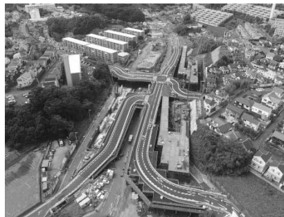
②公田地区掘削試験工事 (栄区公田町) 平成30年9月
