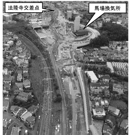
工事実施状況（平成30年9月）
