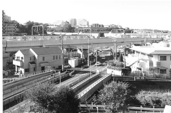
全線高架化後(星川2号踏切)
