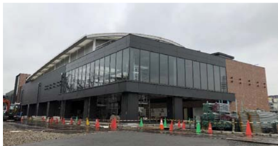
羽沢横浜国大※駅駅舎外観
