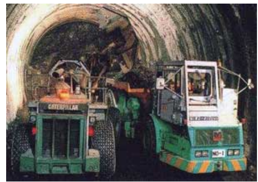
山岳トンネルの工事状況
