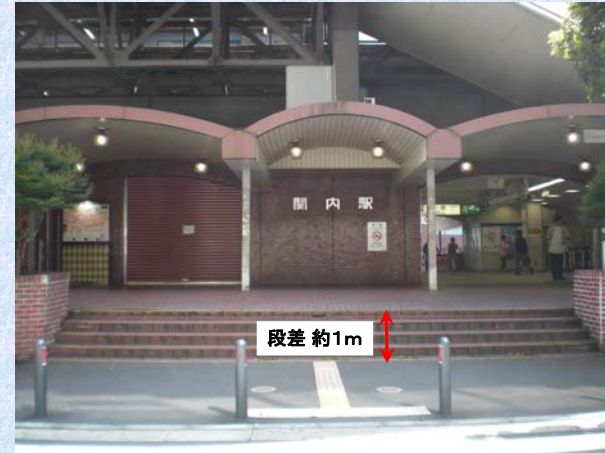
周辺道路との段差 (約1m)
