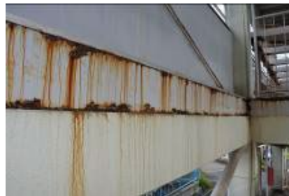
鉄骨の腐食
