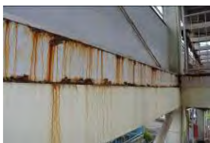
鉄骨の腐食
