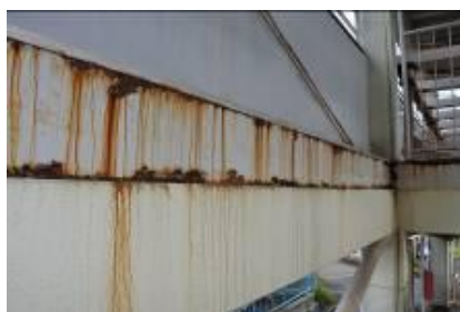
鉄骨の腐食
