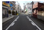
区画線 (減速ドットマーク)
