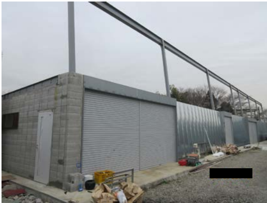
【棟(1)自動車車庫(鉄骨造)】
