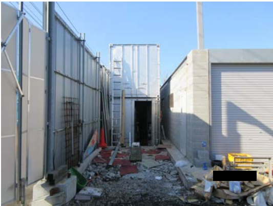
【棟(2)倉庫(コンテナ)】
