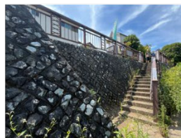
◆護岸 間知ブロック積（石積み風）護岸、
