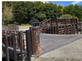
◆転落防止柵 護岸上：擬木柵(縦格子)、出合い橋：天然木(縦格子)
