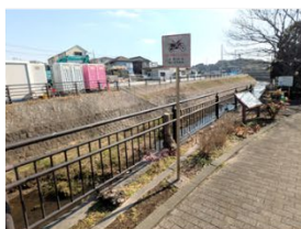
◆転落防止柵 右岸側：縦格子・ダークグレー系、左岸側：横桟型・ダークグレー系
