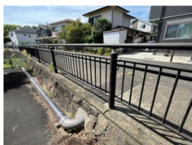
◆護岸 石積み(布積み)護岸
