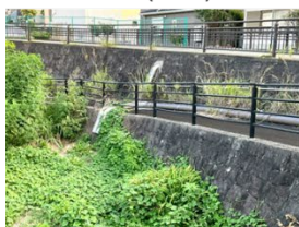
◆護岸 石積み(布積み)護岸
