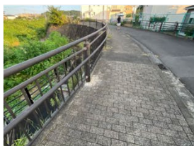
◆転落防止柵 右岸側：縦格子・ダークグレー系、左岸側：横桟型・ダークグレー系
