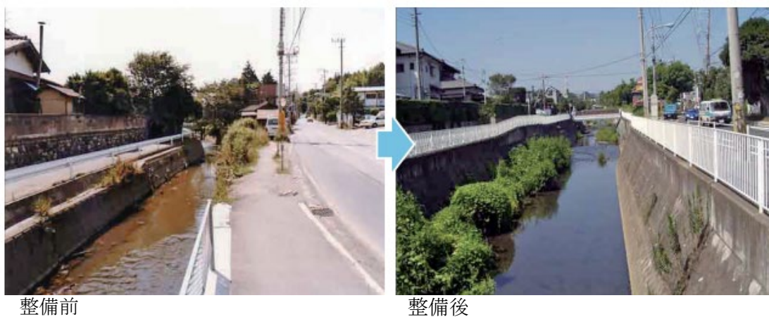
写真 2.3.1 河道拡幅の例
