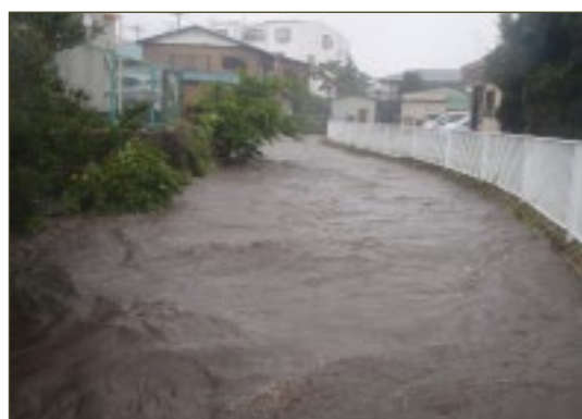
写真 2.2 平成 28 年 8 月(台風 9 号) 川井橋上流
