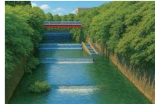
水辺のふれあいと河床・水際の自然環境を創出する、緑・支川・旧河道と調和した川づくり
