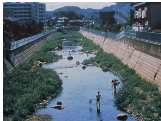
写真2-4 低水路整備（整備後）
