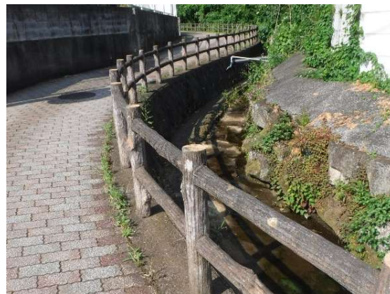
写真3-2 人工素材を用いた転落防止柵
