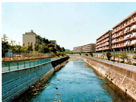
写真 2-3 低水路整備（整備前）
