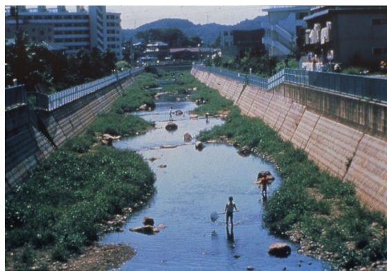
写真 2-4 低水路整備（整備後）
