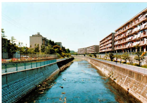
写真 2-3 低水路整備（整備前）
