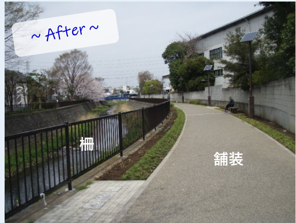
舗装・柵設置
