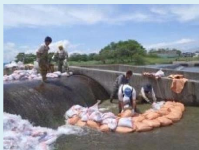
土嚢を使った簡易魚道の例
