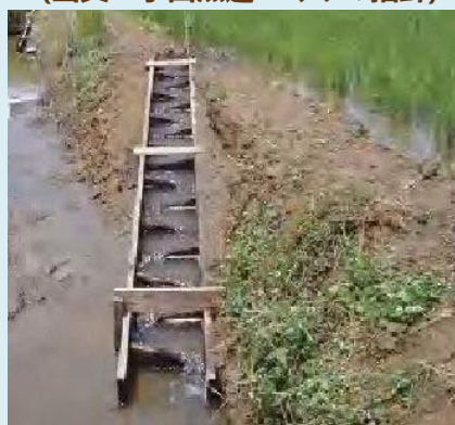
半割コルゲート管を利用した魚道 (出典：水田魚道づくりの指針)
