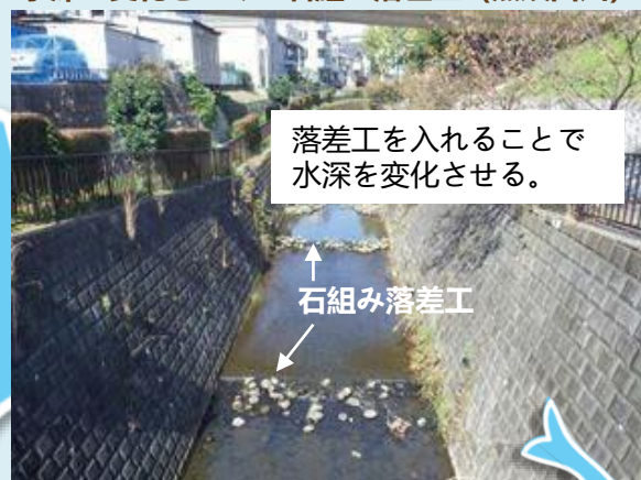
水深に変化をつける石組み落差工（黒須田川）
