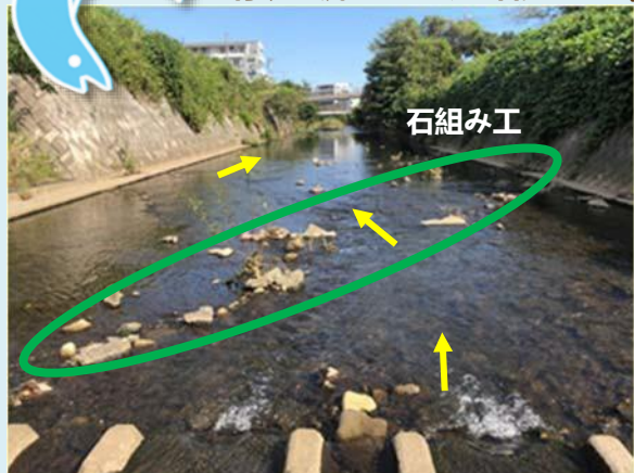
蛇行する流れをつくる石組み工（帷子川）
