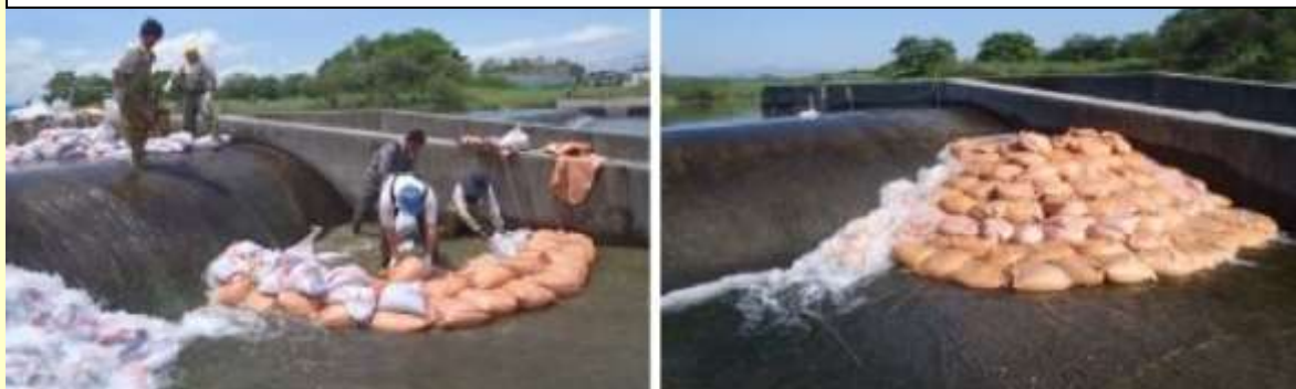
土嚢を使った簡易魚道の例(多摩川)
