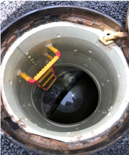
写真－１ 人孔更生工法の施工後
