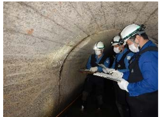
図-1 H27 幹線点検状況
