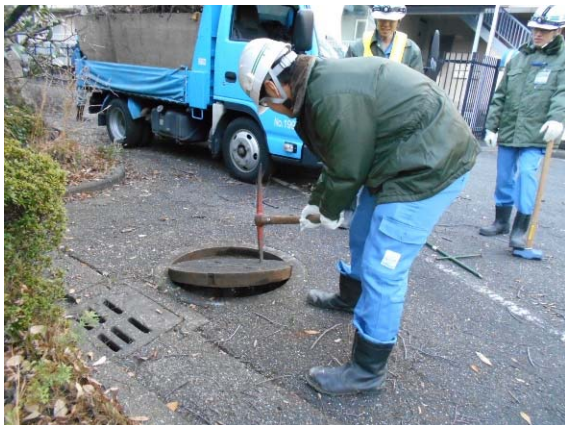
写真－2 ツルハシでのコンクリート蓋の開閉
