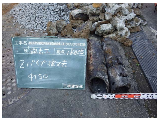
写真-1 Z パイプ
