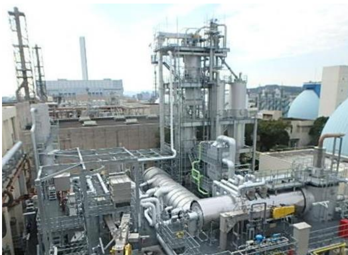
写真－1 汚泥燃料化施設全景
