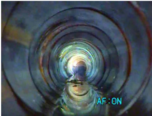
写真－3 管口カメラ撮影画像
