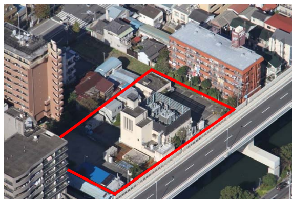
写真 - 1 万世ポンプ場空撮写真
